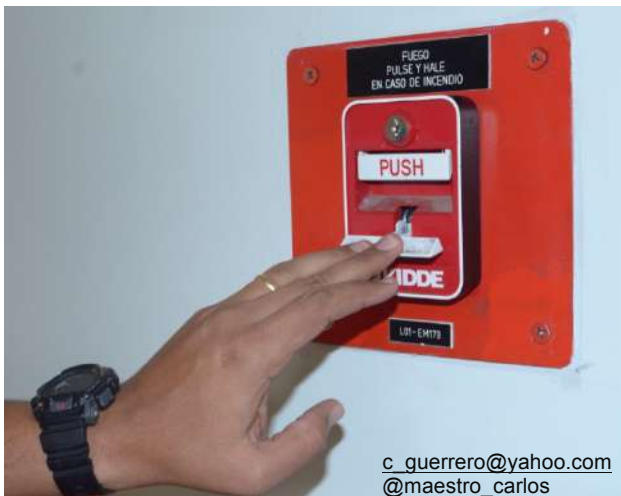
Foto #15: Prueba anual de estación manual
