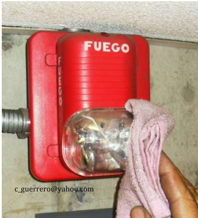
Foto #6: Mantenimiento anual de luz estroboscópica
